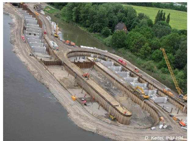
Abb. 4.4-2: Bau der zweiten Fischtreppe am Wehr Geesthacht, rechtes Ufer, km 586 (01.06.2010)
