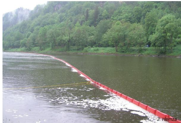
Abb. 5.3-2: Test eines neuen Typs Ölsperre in der Elbe, km 729,5 am 06.05.2009
